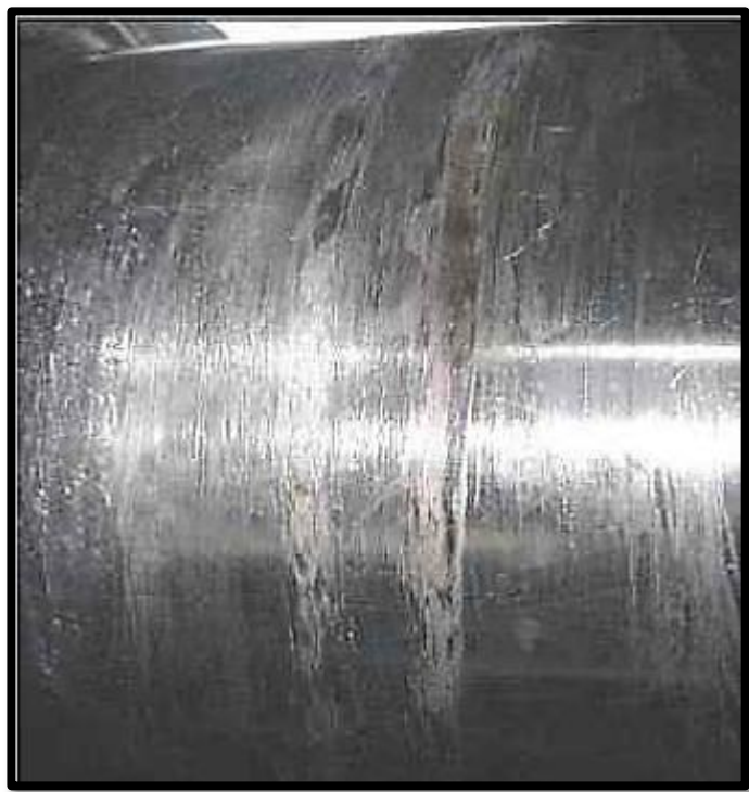
Figura N°87: Desgaste ocasionado por efecto metal con metal
